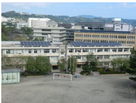
図3 名山小学校の太陽光パネル(鹿児島県鹿児島市)
